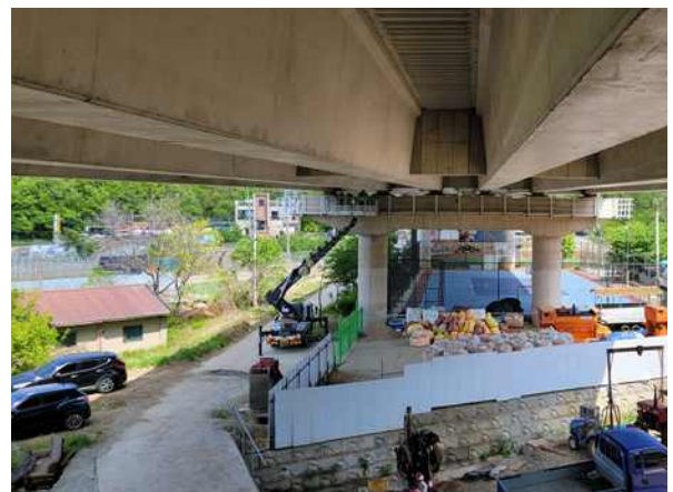
고소작업차를 이용한 근접조사
