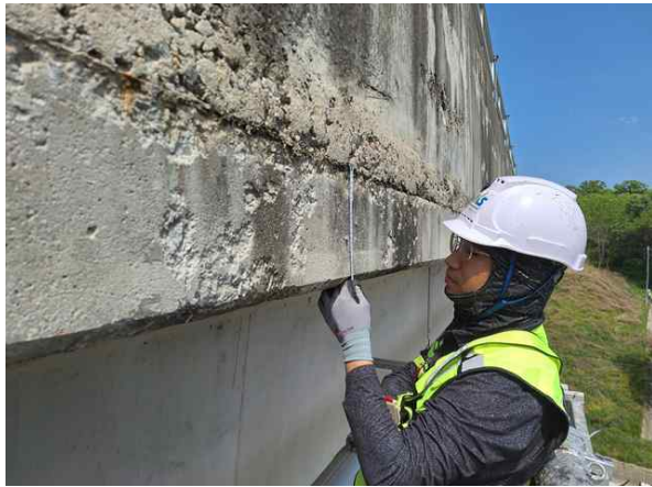
고소작업차를 이용한 부재치수 현장측정
