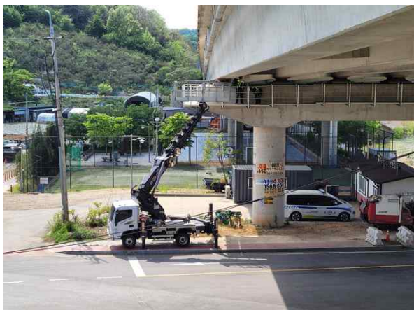
고소작업차를 이용한 근접조사
