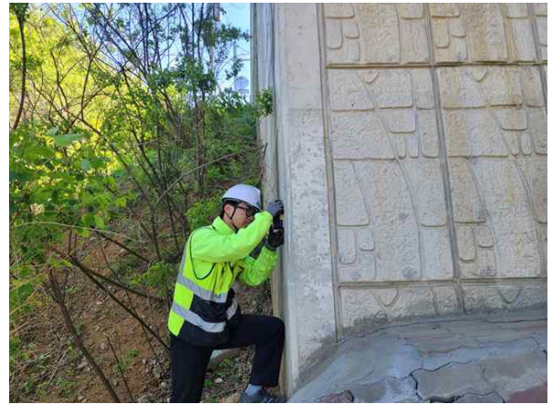
교대 기울음 현장측정
